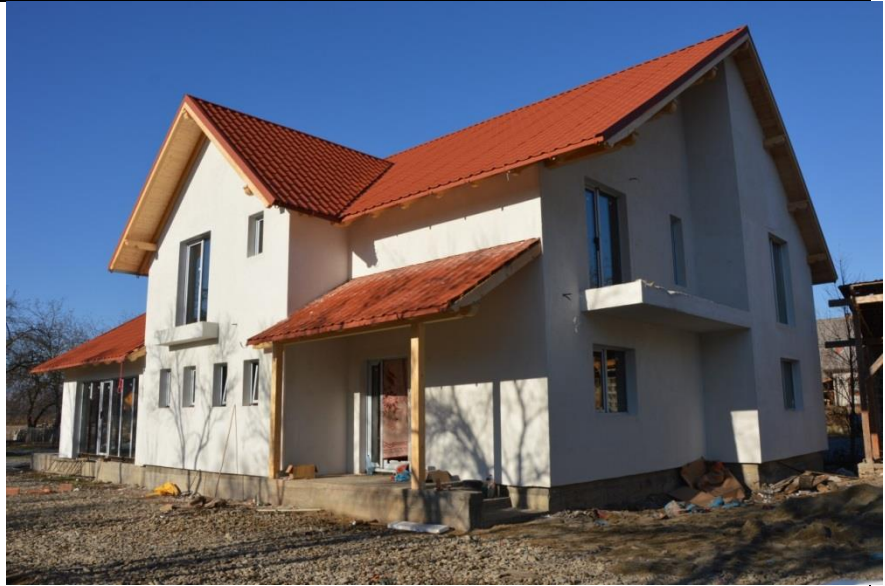
Demolare anexe existente/Modernizare pensiune agroturistică existentă prin extinderea cu un corp nou de construcție (2019)
